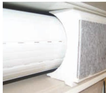
Coffre à isolation thermique et acoustique
