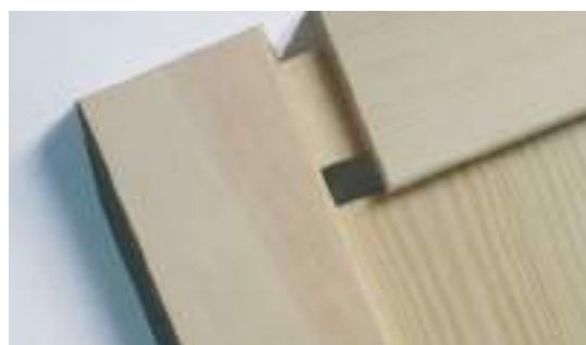
Assemblage par tenon et mortaise
